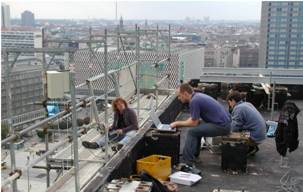
Abbildung 3: Installieren eines Netz-Knotens auf dem Berliner „Haus des Lehrers“
