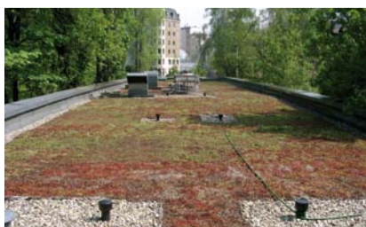
Grün-buntes High-Light: Das neue Flachdach des Hauses 15 in der Philippstraße 13.
