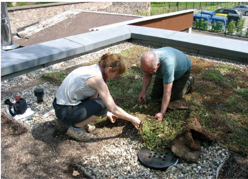
Mitarbeiter des IASP beim Verlegen der vorkultivierten Vegetationsmatten. Fotos: IASP
